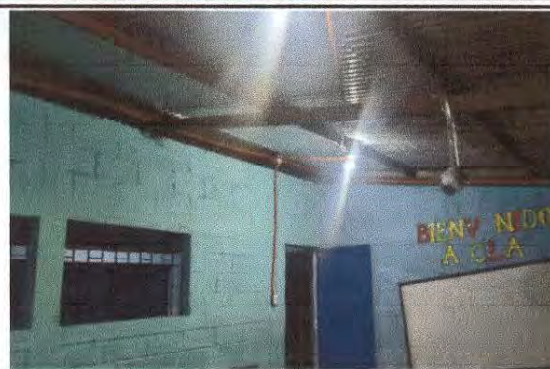
Foto 2: Mejoramiento de sistema electrico aulas modulo 2
