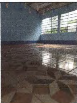
Foto 5: Sustitución de piso torta de cemento por piso cerámico en 1 aula
