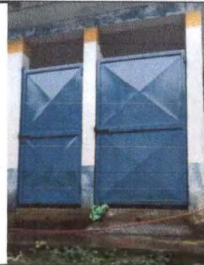
Foto 2: Mantenimiento y pintura de puertas de servicios sanitarios modulo 1
