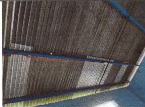
Foto 2: Sustitución de 40 mts. De lámina en cocina escolar, modulo 2
