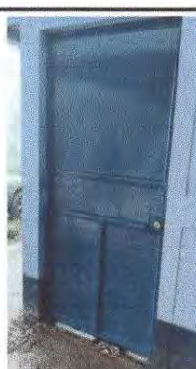
Foto 4: Mantenimiento y pintura de puerta de cocina modulo 2
