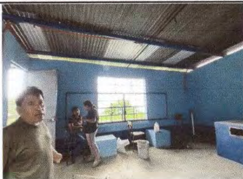
Foto1: Sustitución de 40 mts. De lámina en cocina escolar, modulo 2
